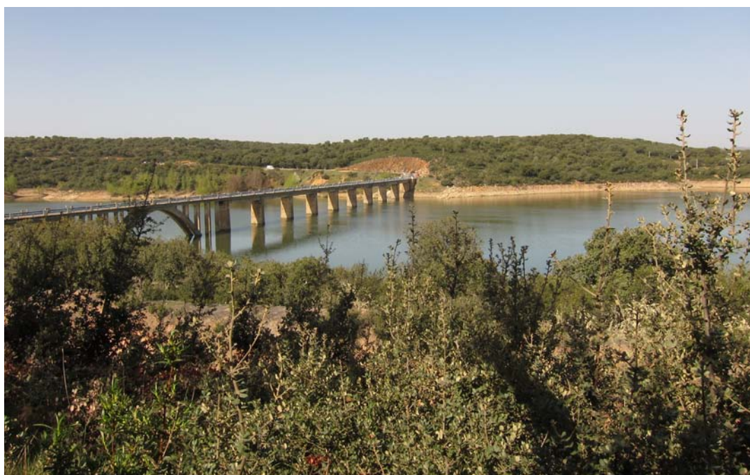
Puente sobre el embalse de Ricobayo en Corrales (Zamora) (Fuente: GA-UPM)
